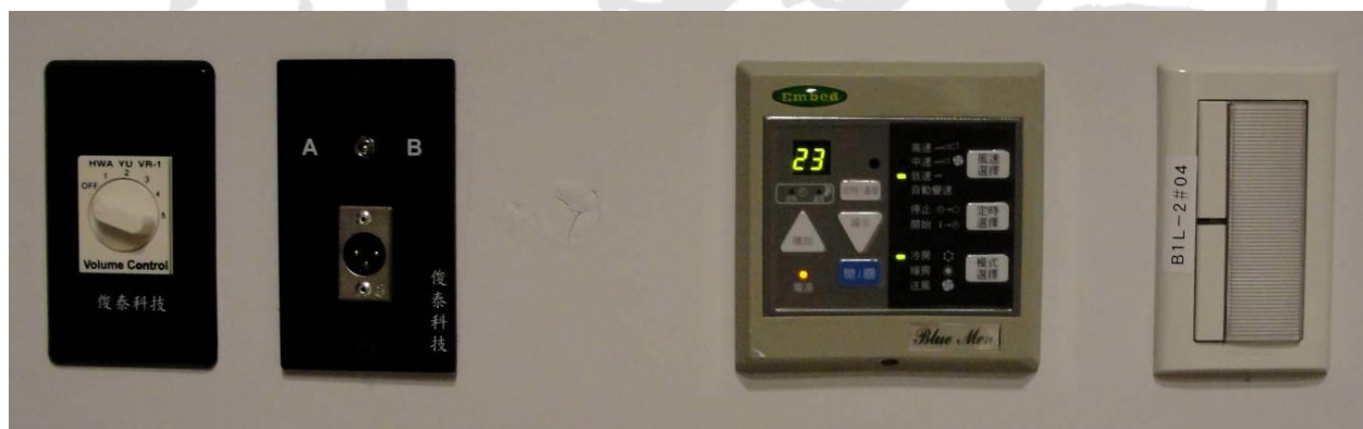
C. 控制室牆壁面板
