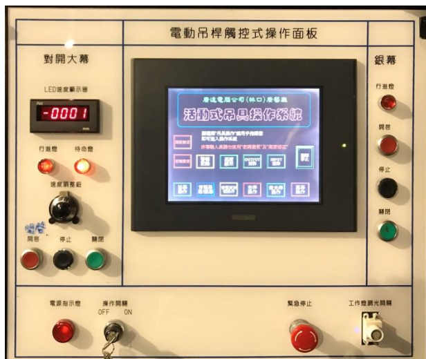
A. 懸吊控制系統
